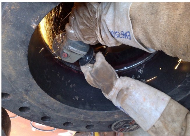
Figura 3.5 – Limpeza da solda de raiz e preparação da superfície para receber a contra solda.
