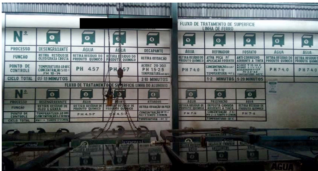
Figura 4.2 - Tanque de lavagem das peças.
