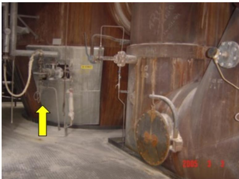
Figura 2.5. Queimador de óleo BPF (vista lateral da fornalha) [8].
