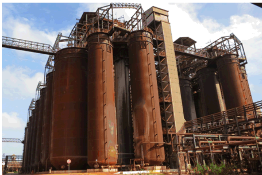
Figura 1.2: Foto da cadeia de precipitadores da Hydro Alunorte.
