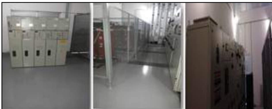
Figura 5.5 - Subestação da planta fabril da empresa BETA.
