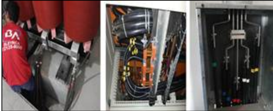
Figura 5.6 - Pontos de execução das atividades do circuito elétrico.
