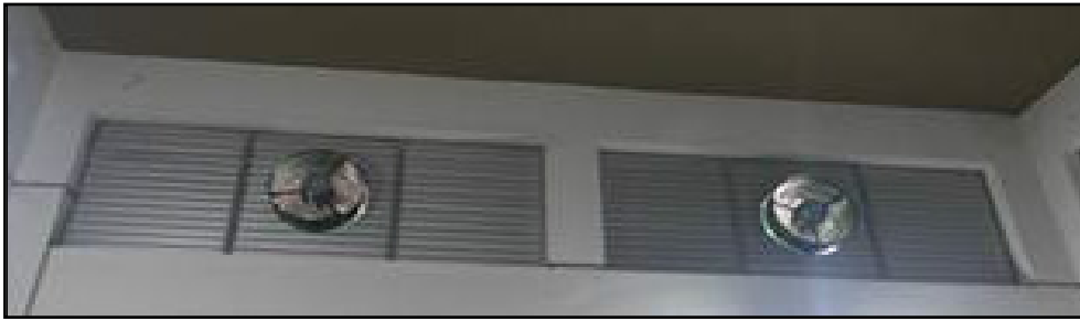
Figura 5.8 - Exaustor instalado na subestação.
