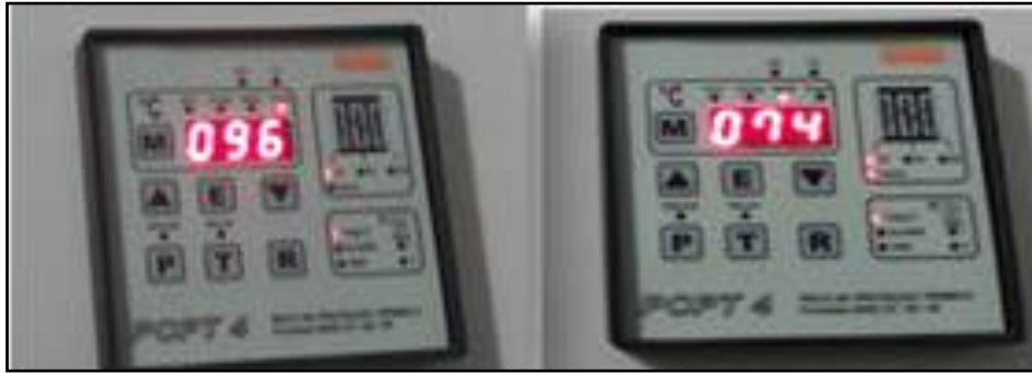
Figura 5.9 - Equipamento medidor de grandezas elétrica.
