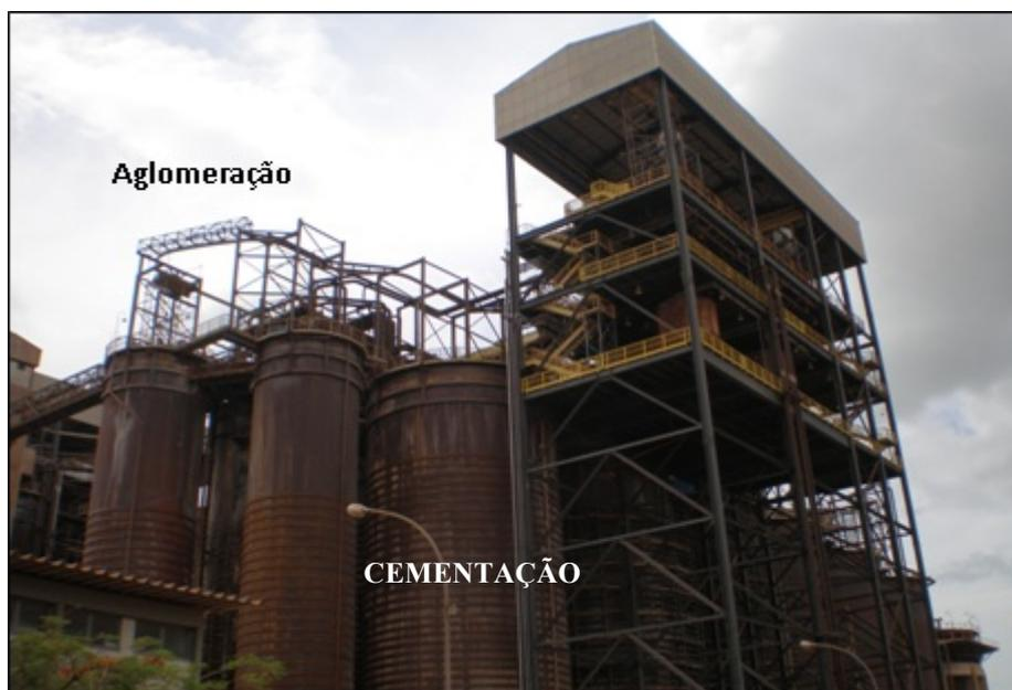
**Figura 2.16** – Tanques da aglomeração e cementação da Hydro Alunorte. Fonte: AMARAL (2004).
