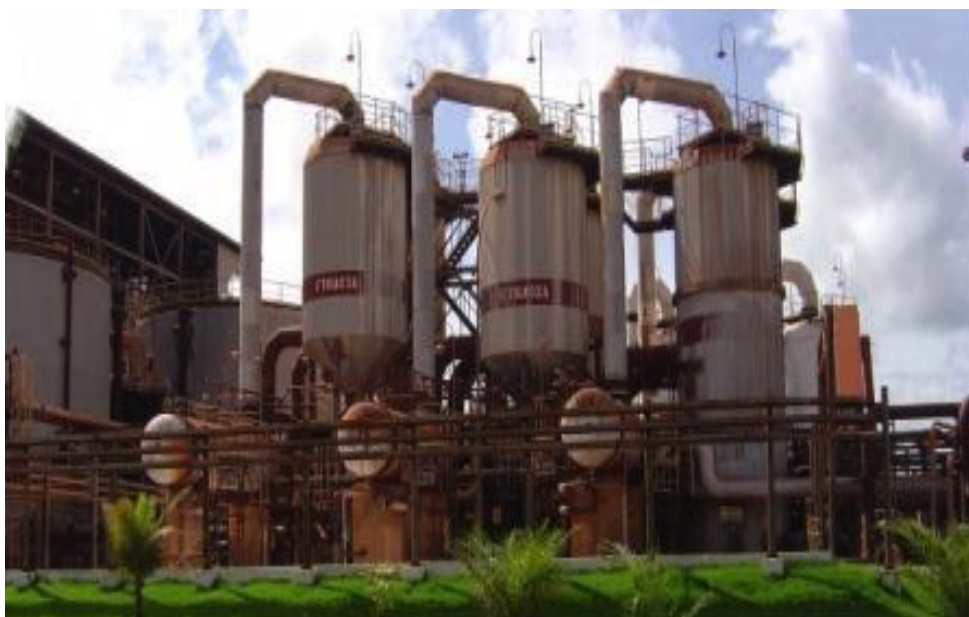
Figura 2.7 – Flash Tank . Fonte: Hydro Alunorte (2008).
