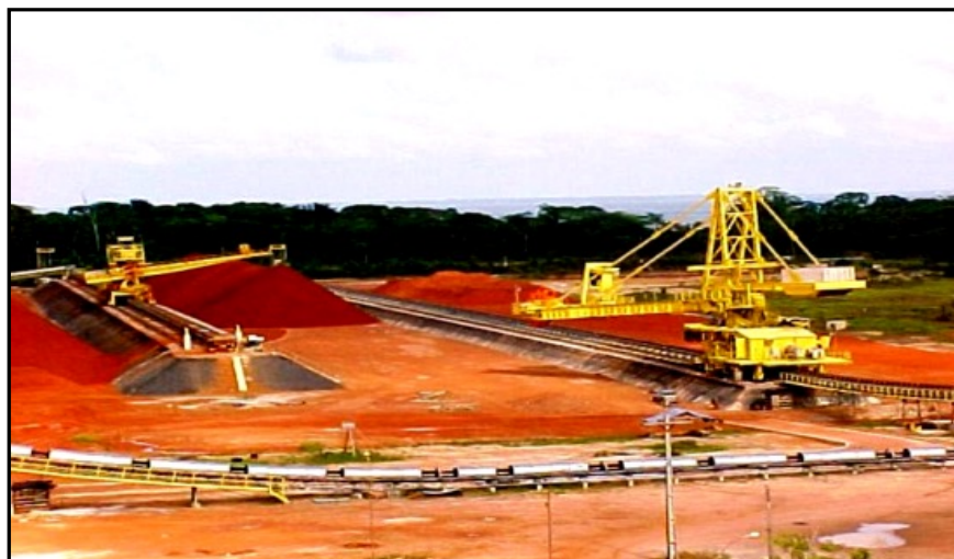
Figura 2.2 - Pátio de estocagem de bauxita. Fonte: Hydro Alunorte (2008).
