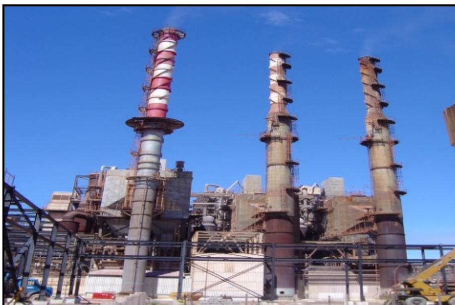
Figura 2.9 – Calcinadores. Fonte: Hydro Alunorte (2008).
