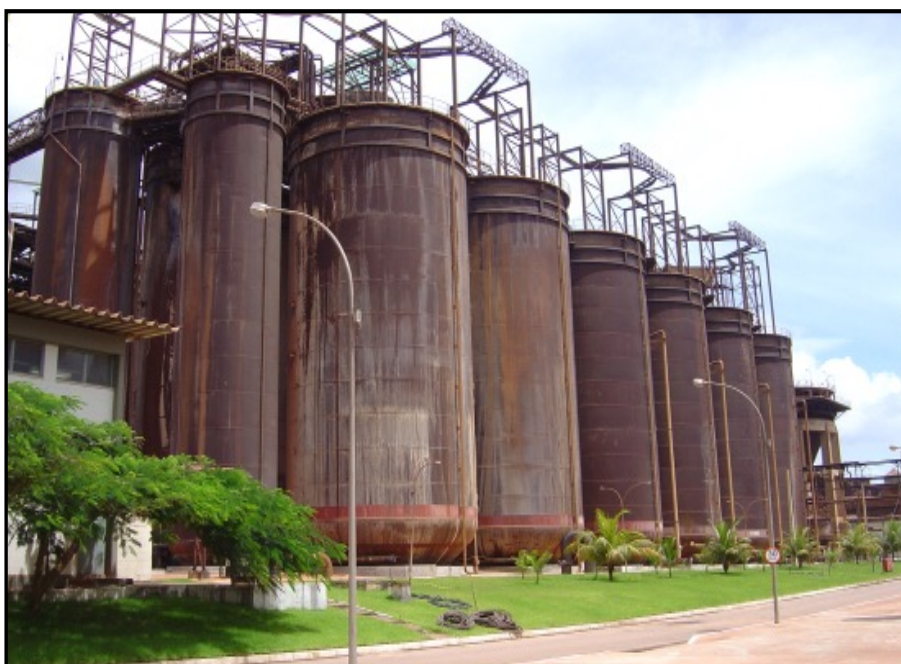
Figura 2.8 - Precipitadores de hidrato de alumínio. Fonte: Hydro Alunorte (2008).
