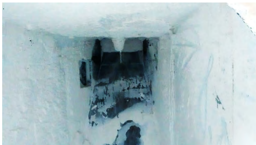
Figura 4.16 - Tanque de descarga do moinho E-8D-2X, vista de cima (da abertura do tanque) após a lavagem cáustica.
