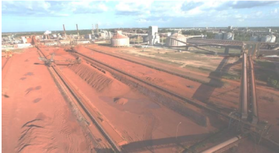
Figura 2.2 - Pátio de estocagem.
