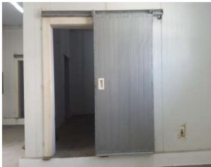
Figura 4.31 - Entrada do túnel de congelamento e interior do túnel de congelamento.
