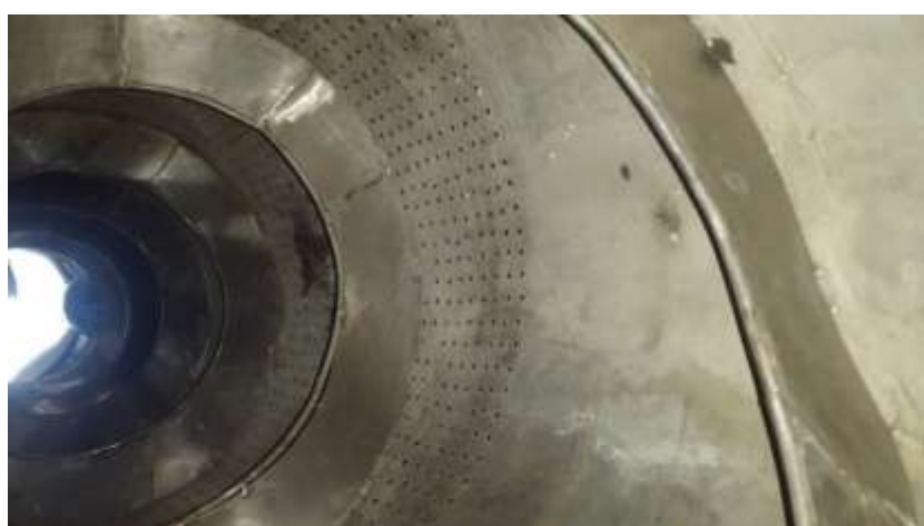
Figura 4.28 - Vista interna do cilindro de lavagem e descontaminação da matéria prima.
