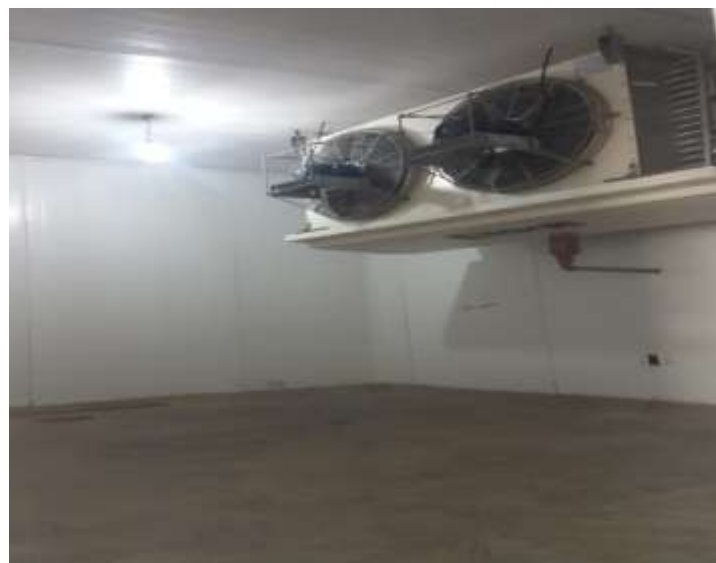
Figura 4.32 - Entrada do túnel de congelamento e interior do túnel de congelamento.
