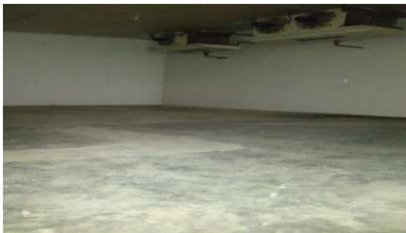
Figura 4.33 - Frigorífico com capacidade 100 toneladas.
