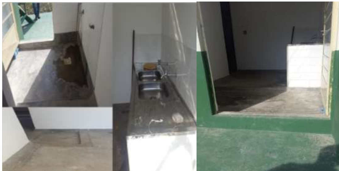
Figura 4.34 - Lavatório de mãos e de botas e pedilúvio, ambos os higienizadores obrigatórios para adentrar o local de manipulação.
