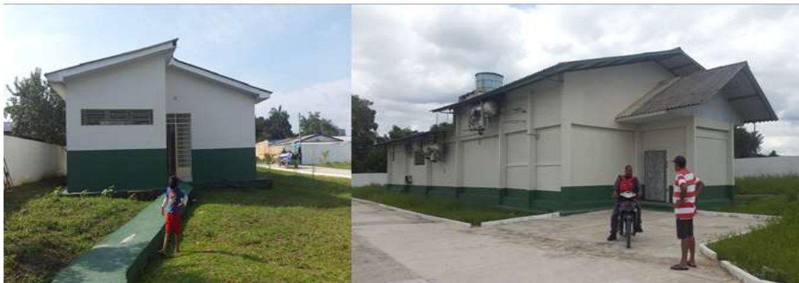
Figura 4.25 - Prédio do entreposto de pescado e prédio administrativo.
