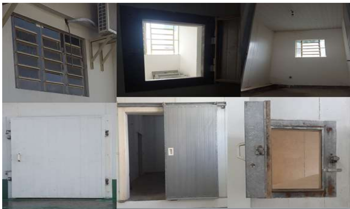
Figura 4.37 - Portas, janelas e paredes.
