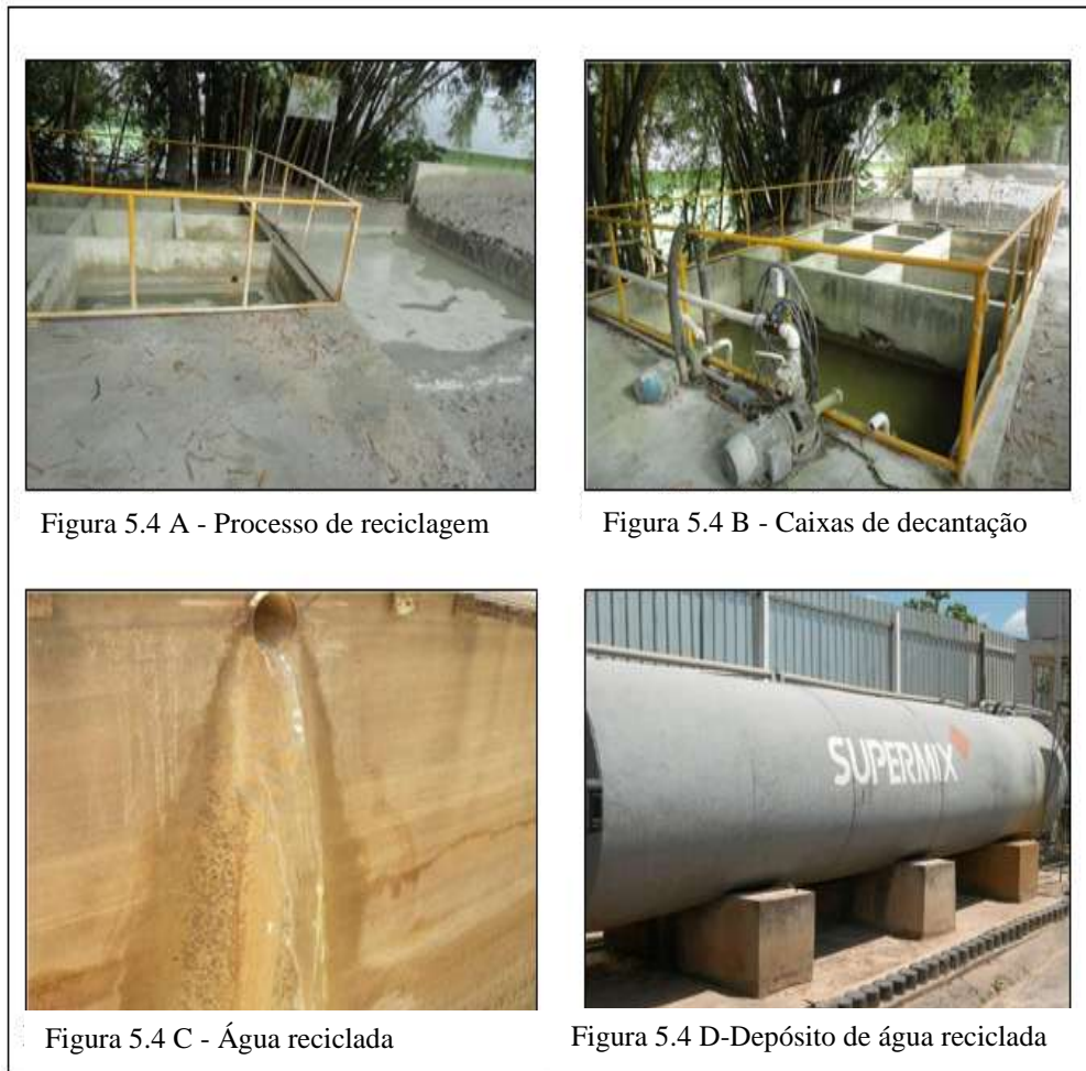
Figura 5.4 - Processo de reciclagem da água.
