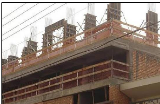
Figura 4.14 – Guarda-corpo e rodapé armados para proteção das equipes. Fonte: http://www.bks.ind.br/produtos/escoramento-metalico/guarda-corpo .
