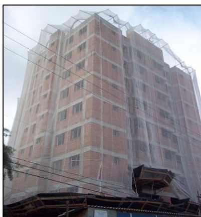
Figura 4.15 – Tela de proteção aramada em obra.
