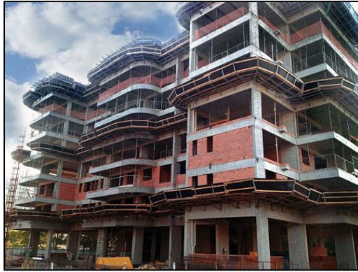
Figura 4.16 – Plataformas instaladas em obra.
