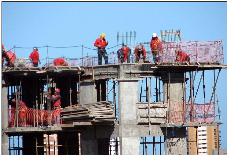
Figura 5.3 – Checar e registrar a montagem dos equipamentos de proteção coletiva. Fonte: http://antoniofcardoso.blogspot.com.br/2015_09_01_archive.html .
