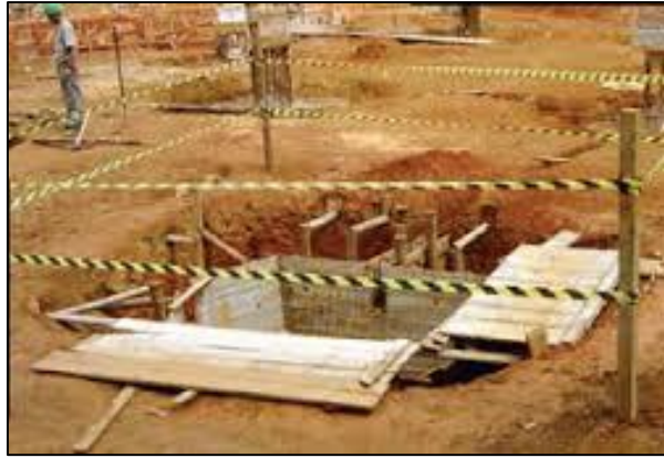
Figura 4.12 – Sinalização com fita zebraada em canteiro de obra.
