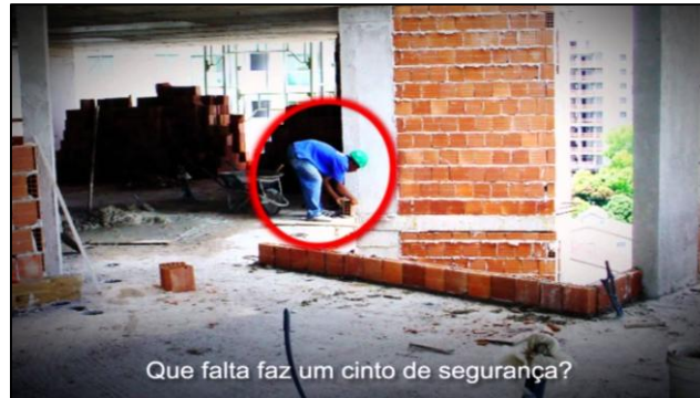
Figura 5.4 – Operário sem EPI que não havia sido considerado previamente.
