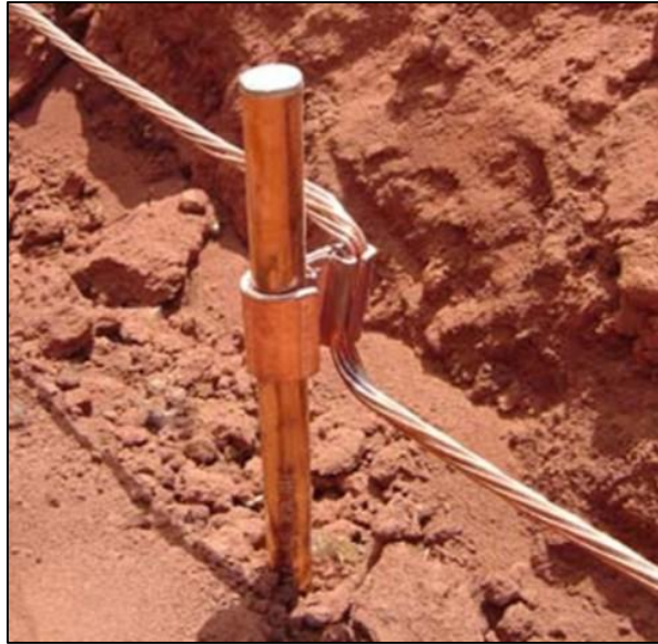
Figura 4.20 – Aterramento elétrico em obra civil. Fonte: http://www.madeireiracaetano.com.br/Dicas .
