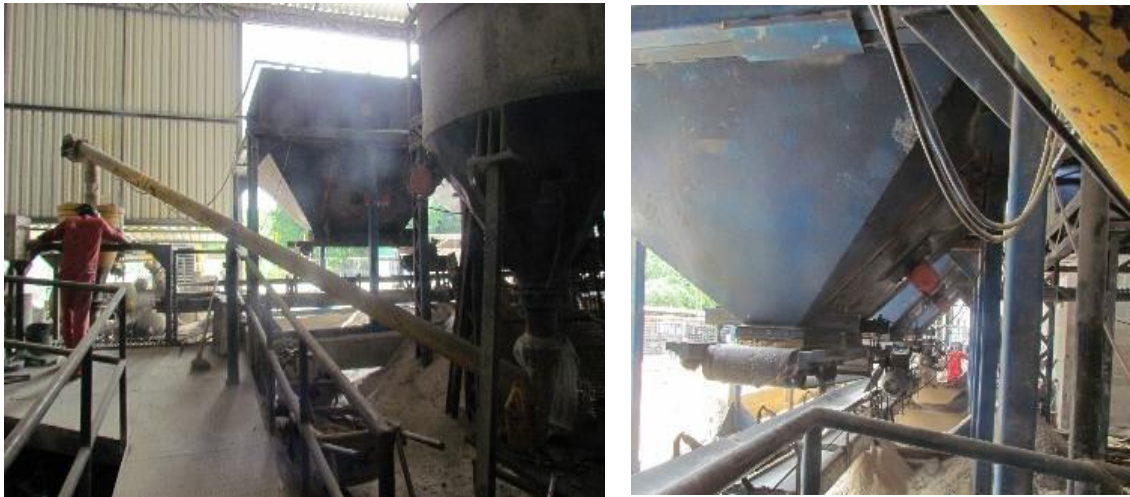
Figura 4.12 - Tanque de água e máquina utilizada pela Empresa B.
