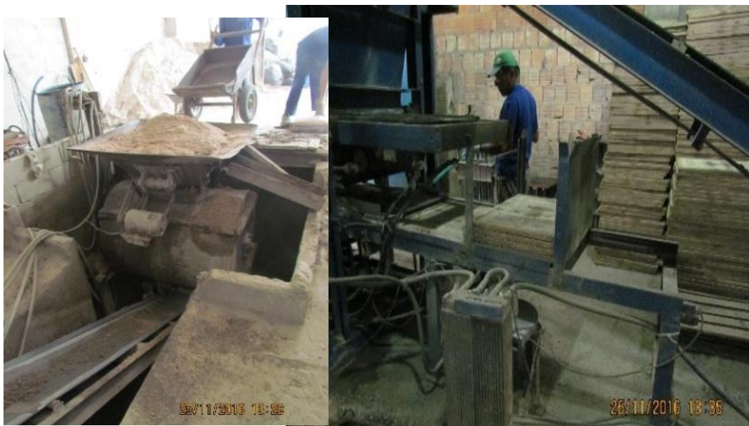
Figura 4.3 - Misturador e máquinas utilizadas. Compensado para colocar o bloco de concreto.
