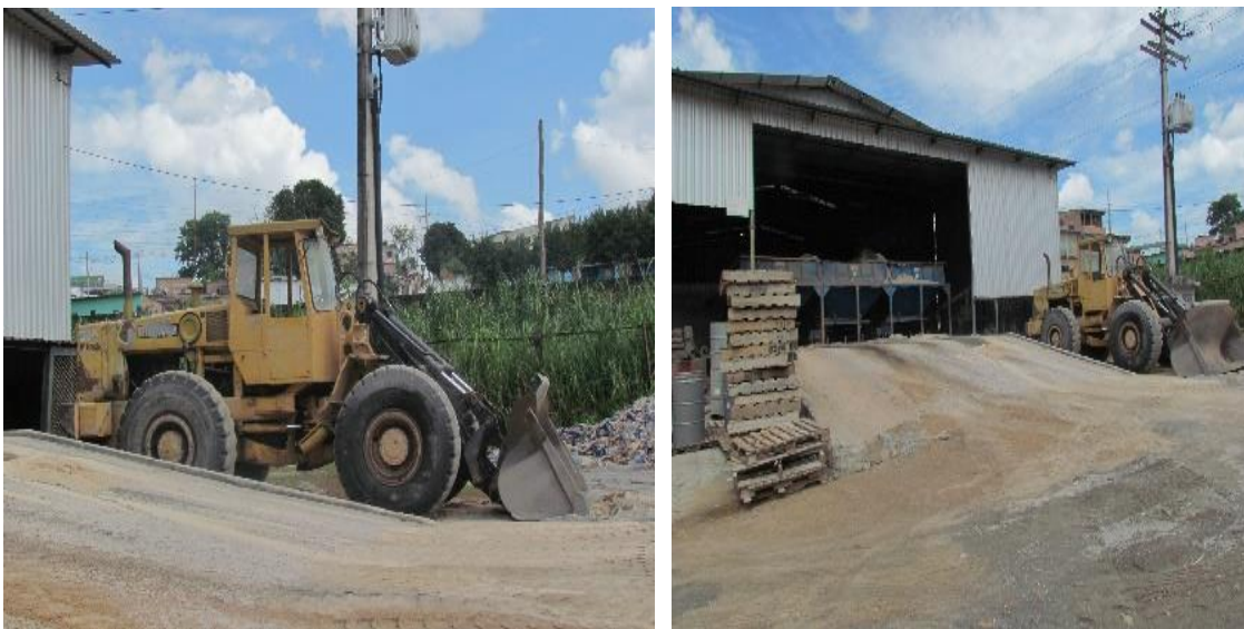
Figura 4.11 - Trator para transportar os materiais e usina de concreto com silos de dosagem.
