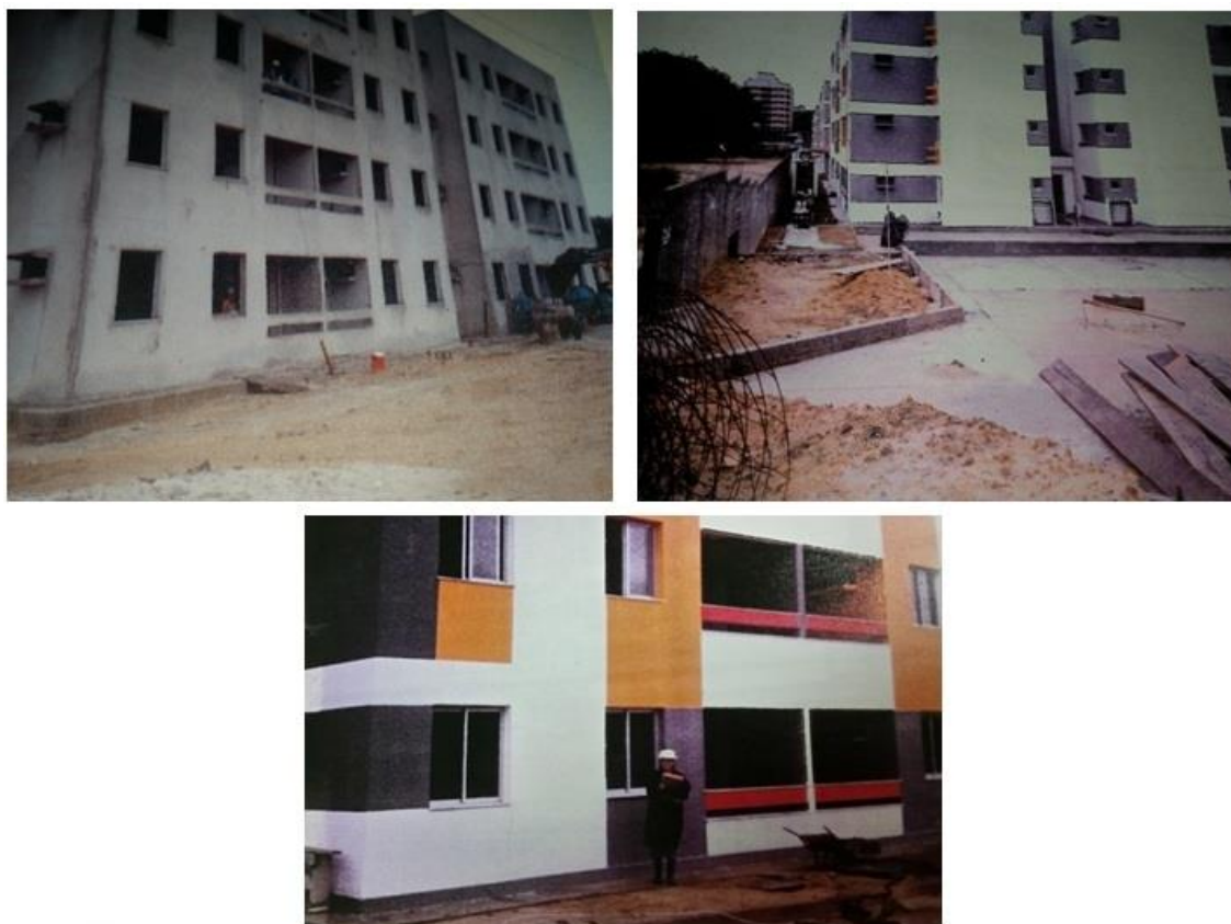
Figura 4.28 - Fachada sem acabamento. Fachadas em fase de acabamento e concluídas.
