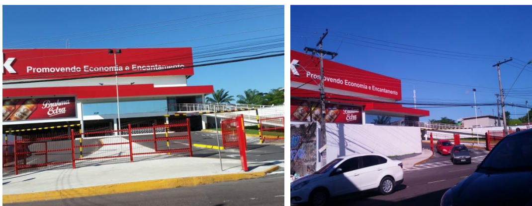
Figura 4.26 - Fachada do Supermercado X - Obra concluída.
