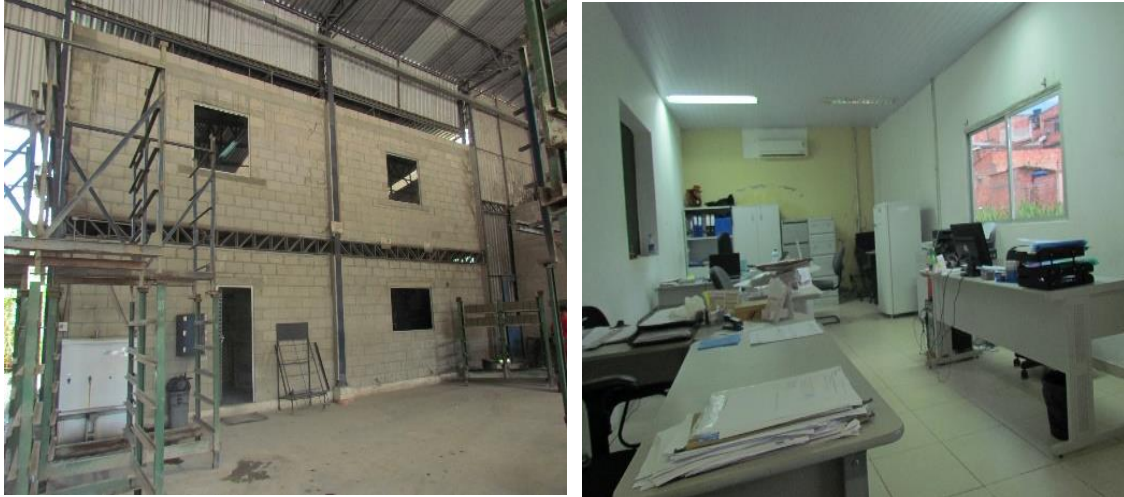
Figura 4.9 - Fachada e ambiente interno do escritório da Empresa B.
