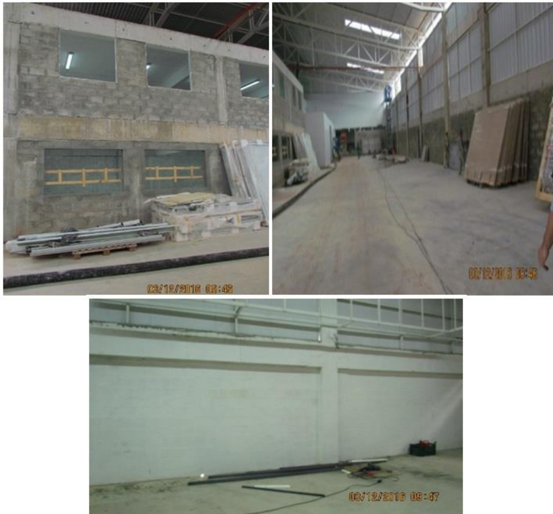
Figura 4.24 - Paredes faltando o acabamento. Um grande vão na parte interna e parede já terminada.
