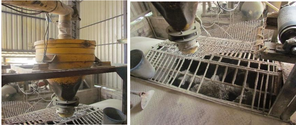
Figura 4.16 - Misturador utilizado dos blocos de concreto para as paredes.
