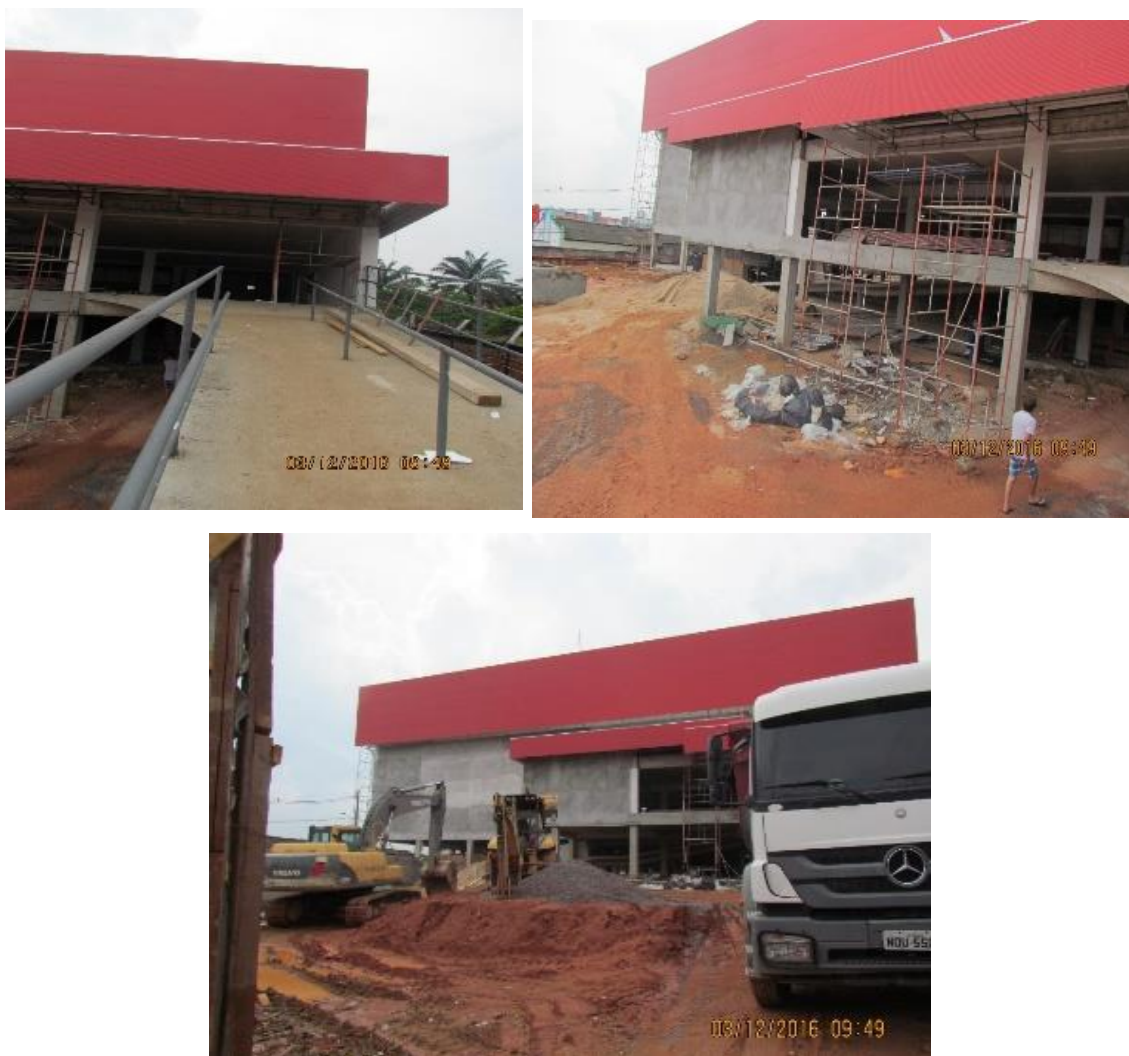
Figura 4.22 - Rampa de entrada e fachada da entrada feita com vedação de bloco de concreto.
