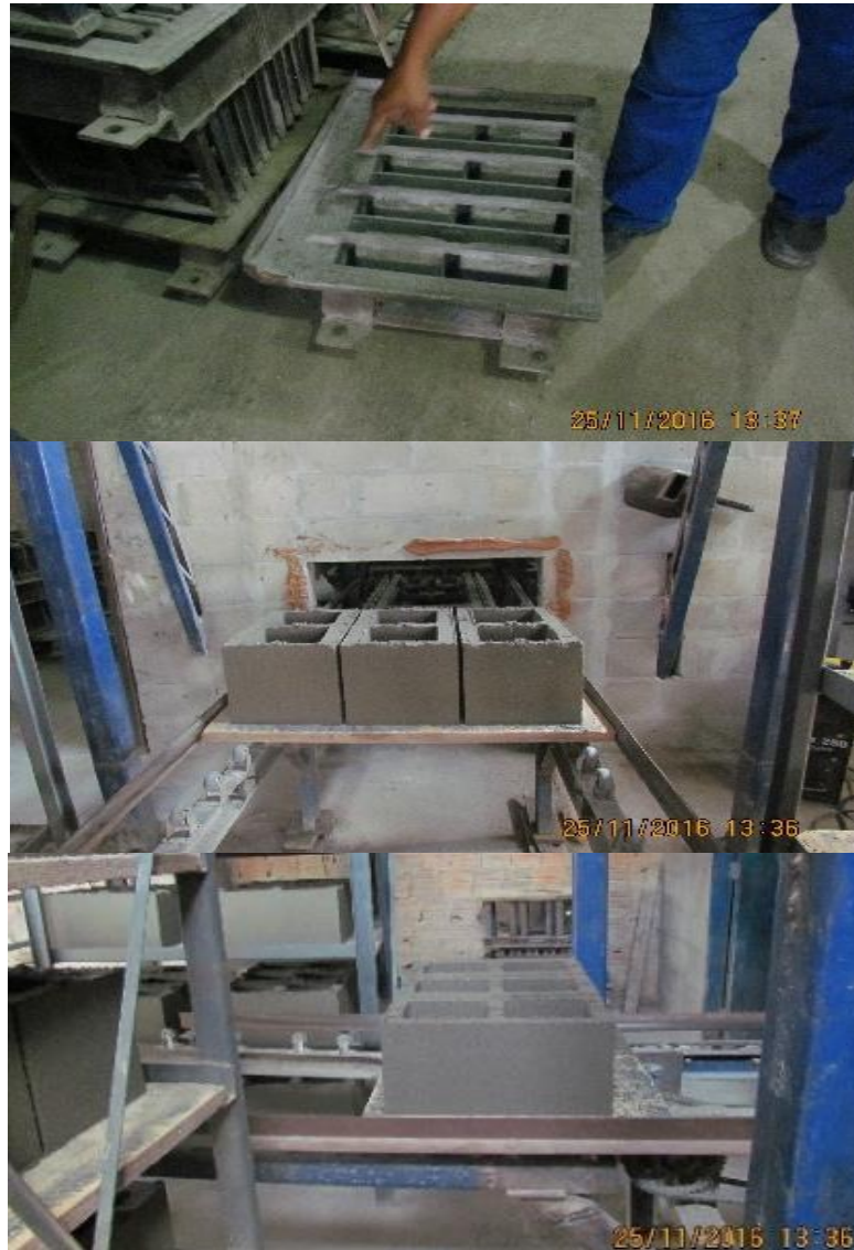
Figura 4.4 - Fôrma para fazer o bloco de concreto. O bloco saindo concluído da máquina.
