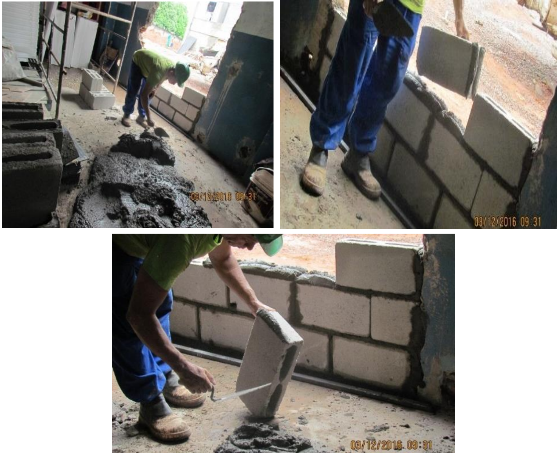
Figura 4.23 - Preparando a massa, colocando o bloco após a massa e fazendo a vedação da parede.
