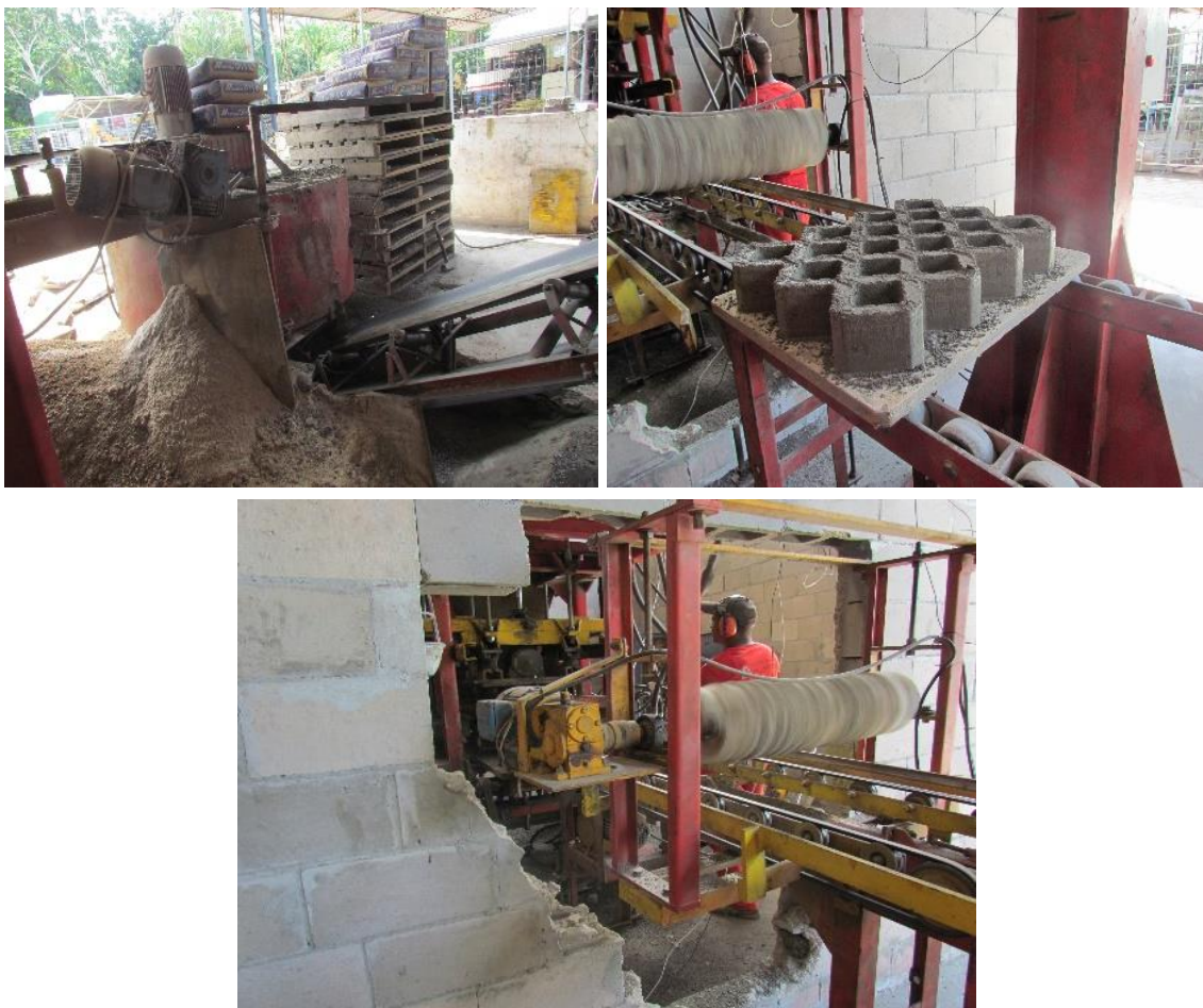
Figura 4.13 - Máquina misturadora. Bloco de concreto para piso e máquina de escovar o bloco.
