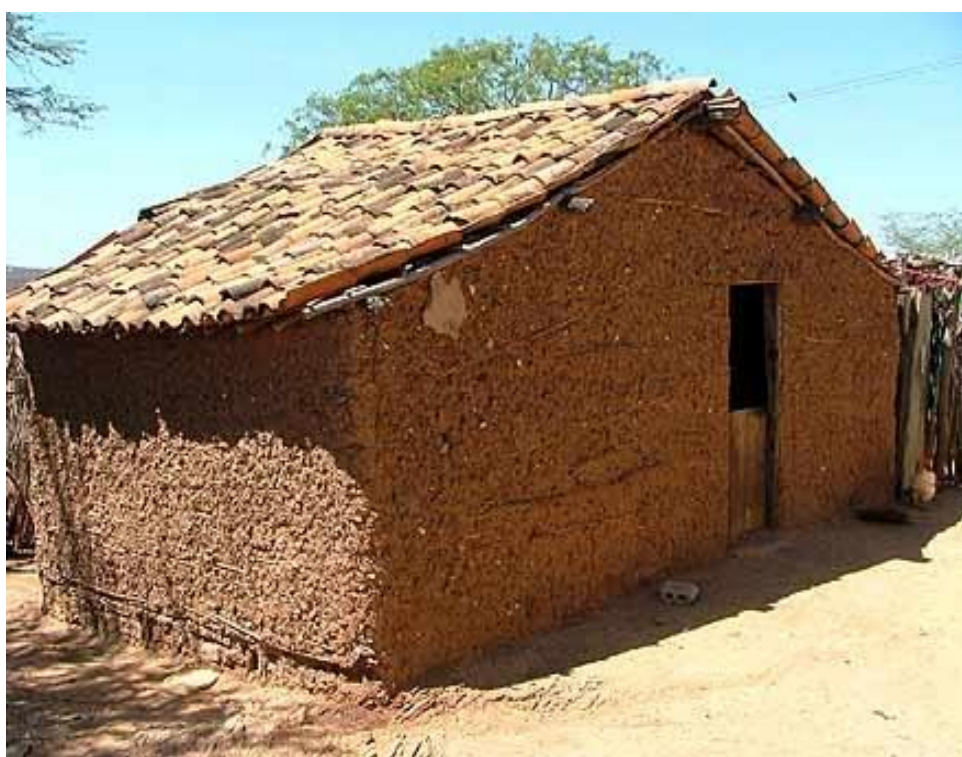
Figura 2.7 - Casa de taipa.
