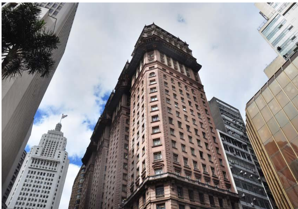
Figura 2.8 - Edifício Martinelli – São Paulo.
