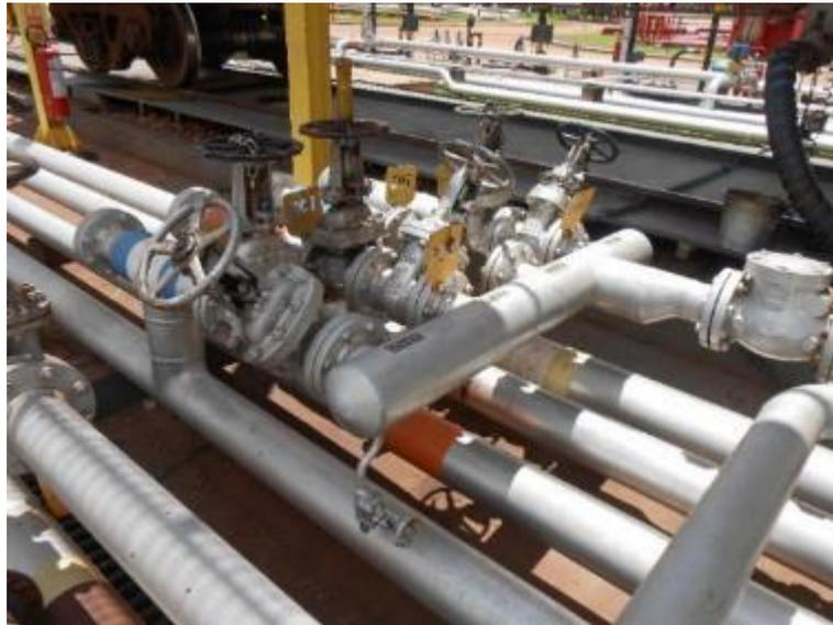
Figura 3.14 - Manifold de descarga existente a ser removido.
