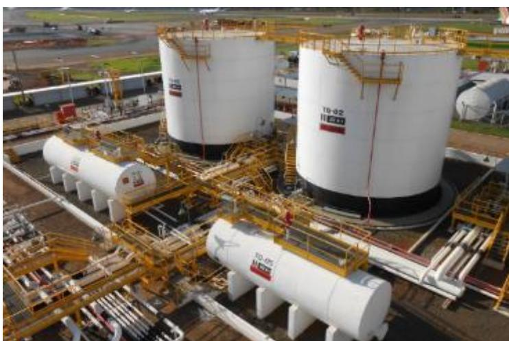
Figura 3.5 - Tanques de armazenamento para combustível de aviação JET-A1. Posto de Abastecimento de Aeronaves do Aeroporto Internacional de Brasília.
