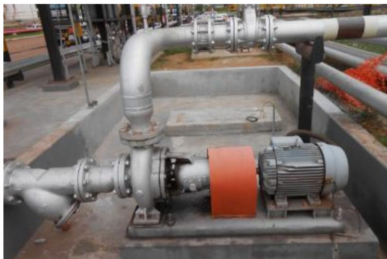
Figura 3.4 - Bomba centrífuga de descarga de S10.
