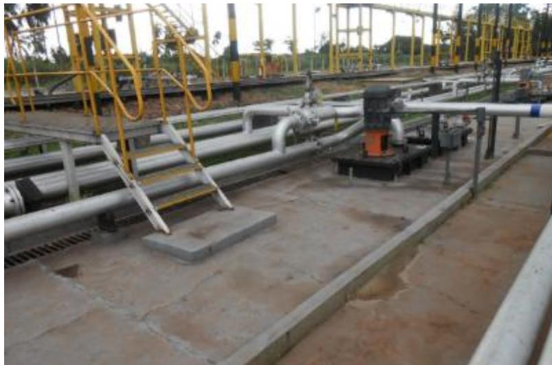
Figura 3.3 - Área dos tanques pulmão enterrados. Notar bomba vertical em destaque.
