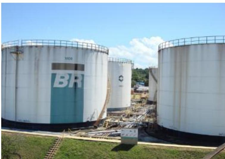
Figura 3.6 - Bacia de contenção de tanques verticais. Terminal da BR Distribuidora - Manaus/AM.
