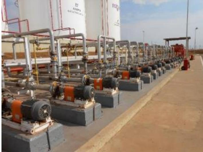
Figura 2.2 - Pátio de bombas centrífugas em Terminal de Distribuição.
