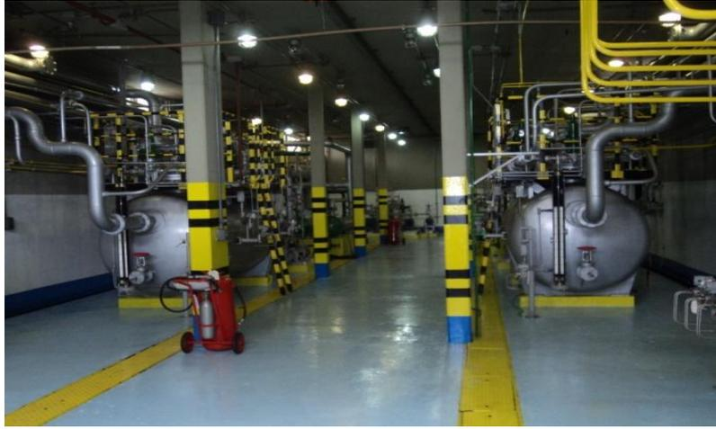
Figura 2.3 - Parte do sistema hidromecânico dos compensadores de Vila do Conde.
