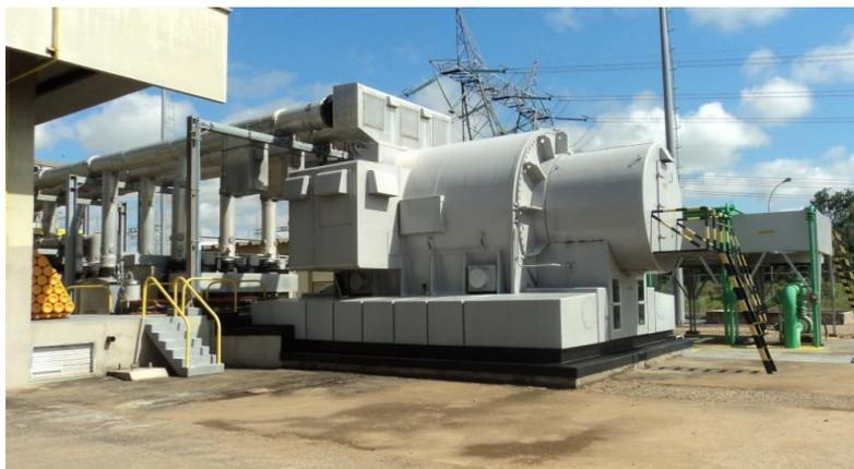
Figura 2.2 - O compensador síncrono de Marabá.
