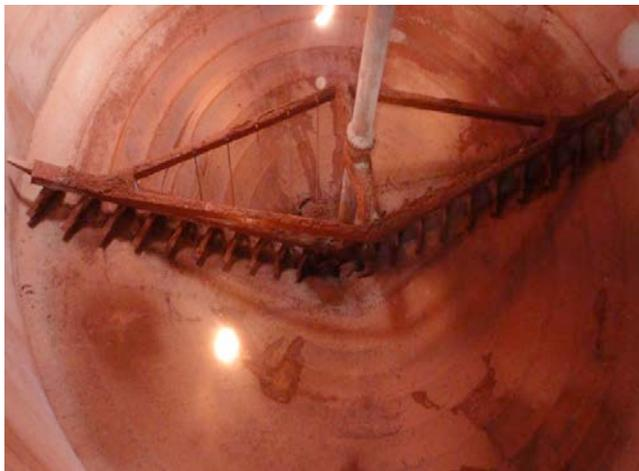
**Figura 4.30** – Fundo e raspa do tanque T-28D-6 após lavagem cáustica.
