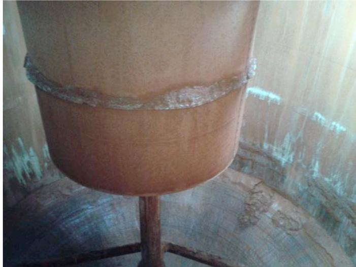
**Figura 4.42** – Interior do tanque T-28C-1X após lavagem cáustica, mostrando as condições da parede, fundo, raspa e feedwell.
