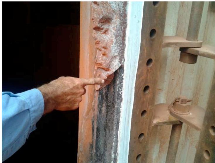
**Figura 3.30** - Fotografia da porta de visita do tanque T-28C-1X, em destaque a espessura da crosta presente na parede.
