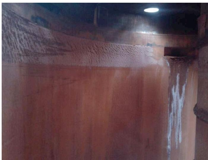
**Figura 4.41** – Interior do tanque T-28C-1X após lavagem cáustica.
