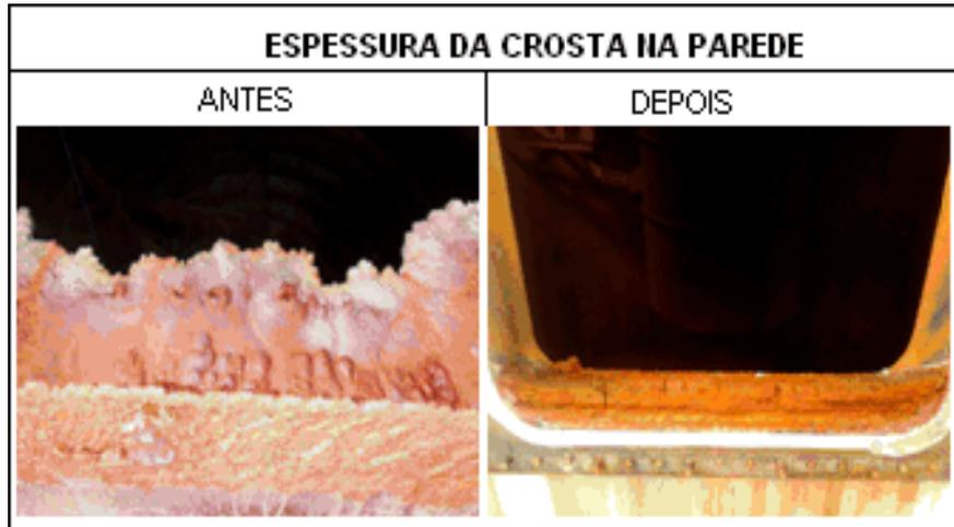
**Figura 4.33** – Fotografias mostrando as condições da borda superior e fundo do T-28D-4 antes e após a limpeza cáustica.
