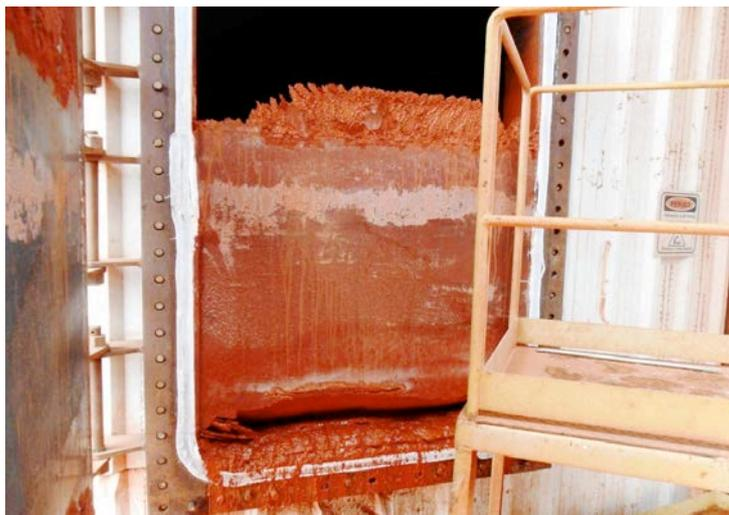
**Figura 3.25** - Fotografia da porta de visita do tanque T-28D-4, destacando a crosta formada na parede interna.
