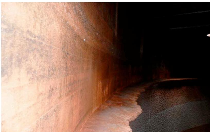
**Figura 3.22** – Fotografia da parede interior do tanque T-28D-12 (tanque de transbordo) mostrando a espessura da incrustação antes da lavagem cáustica.
