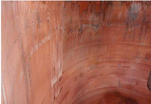
**Figura 4.29** – Parede interior do tanque T-28D-6 após lavagem cáustica.
